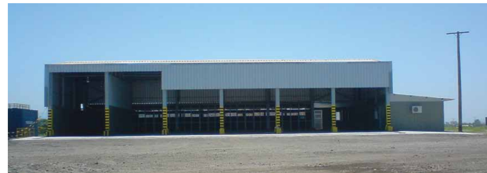
Instalações Resende -RJ
